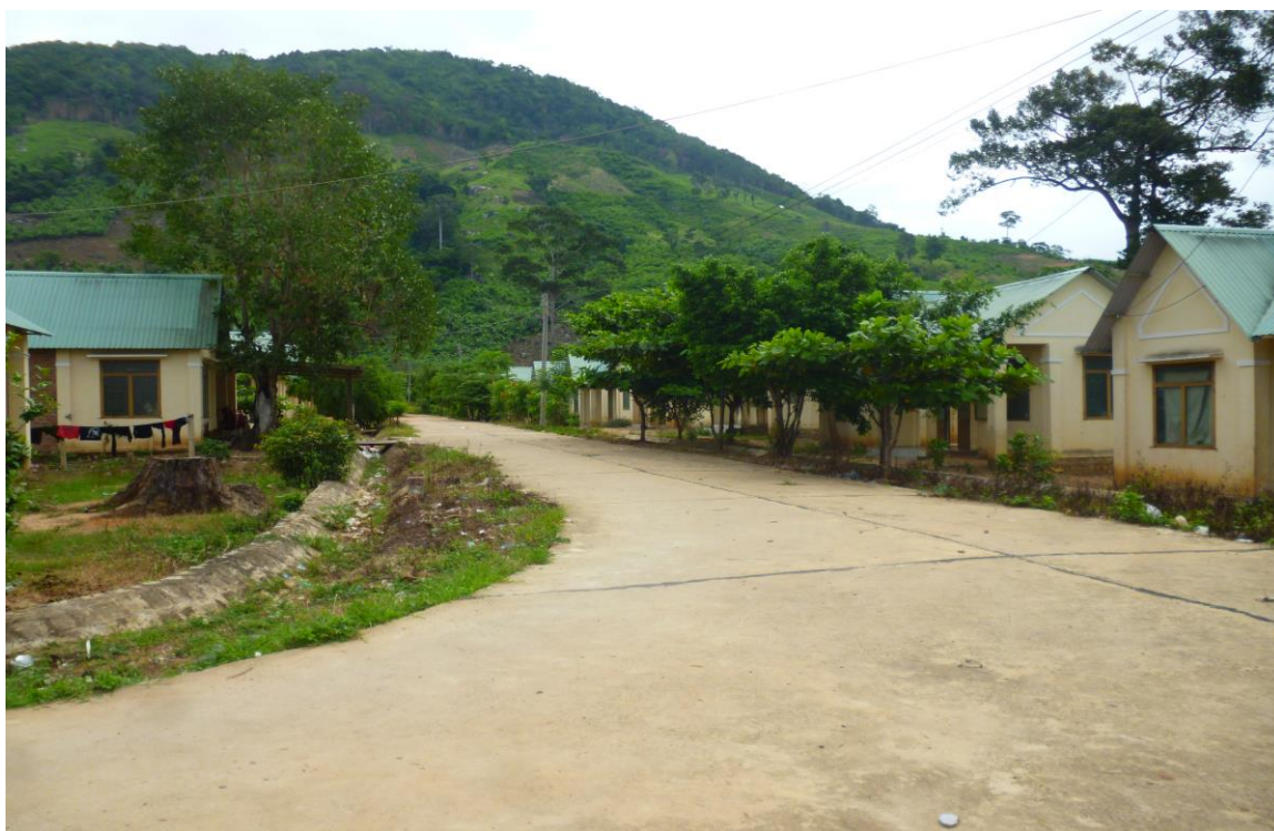
Bê tông hóa đường nông thôn
